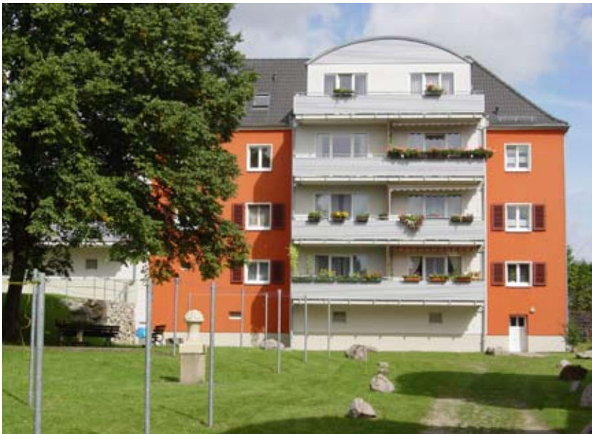
Modernisierung mit Hilfe von Fördermitteln, Philipp-Müller-Straße/Döbereinerstraße
