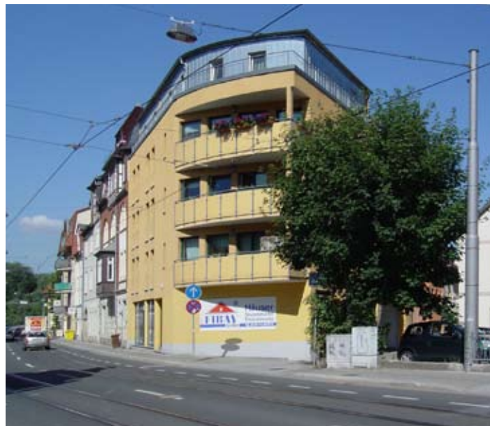
Neubau von Sozialwohnungen, Karl-Liebknecht-Straße
